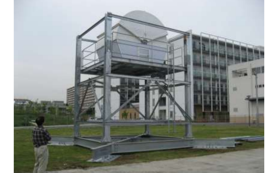
国立極地研究所で雁組みした8mステージと天体観測ドーム
