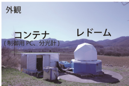
図 1: 野辺山に設置された 1.85m 望遠鏡の外観。左のコンテナ内に制御機器はインストールされている
